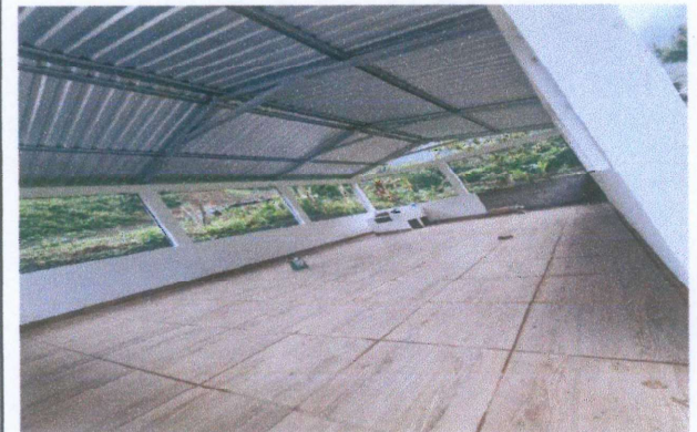
Foto 4: Instalación de polletón para el área de cocina
