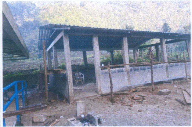
Foto 2: Instalación de lámina troquelada calibre 26
