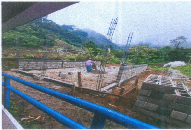
Foto 1: Mejoramiento de estructura tipo pórtico
